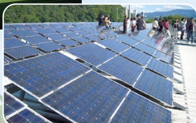
原発よりも発電量が多くなっている太陽光パネル
