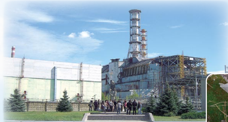
コンクリートで覆われたチェルノブイリ原発4号炉
